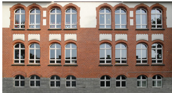
Abb. 6.5 Fassade für die Texturierung
