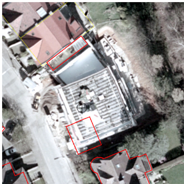
Abb. 5.20 Baustelle im Luftbild und ALK-Situation (rot)
